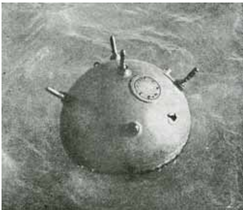
Mina tedesca, funzionante ad urto, diametro cm 85, carica Kg 40
